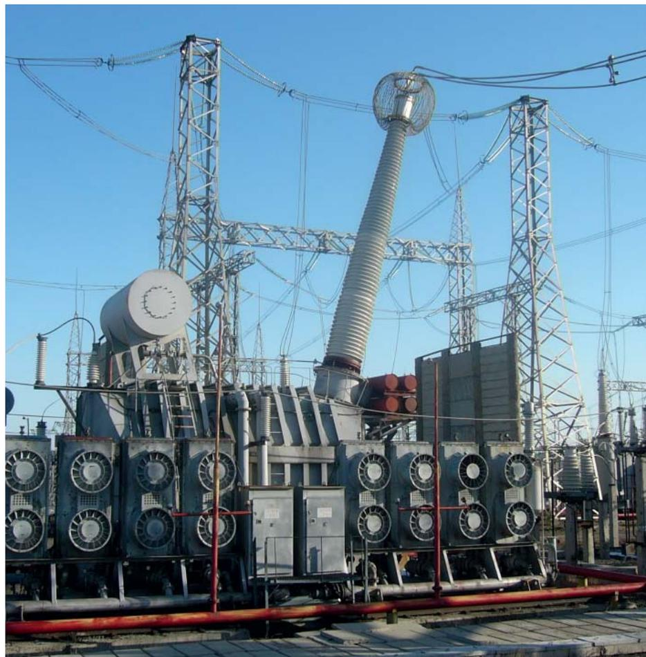
▲ Вводы 1150 кВ на реакторе 300 МВА МЭС Сибири
